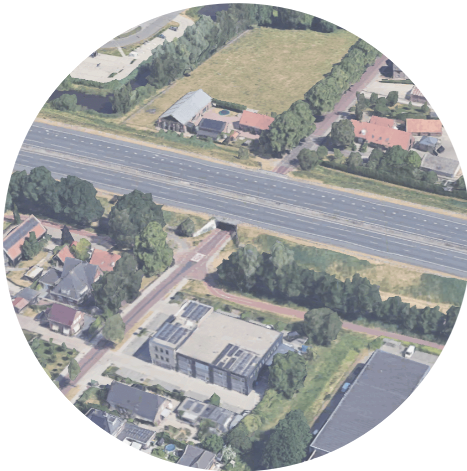
Huidig lint stationsstraat met tunnel onder de A12
