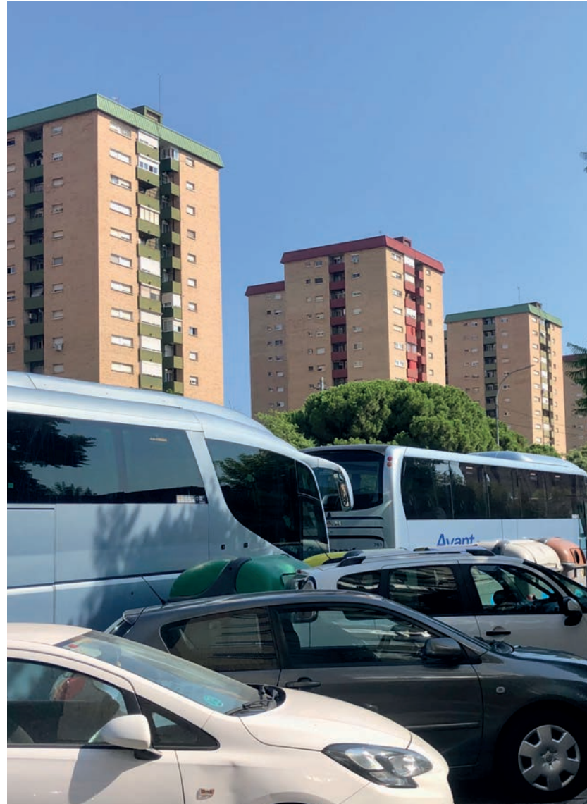
Foto systeembouw in Barcelona 2023
