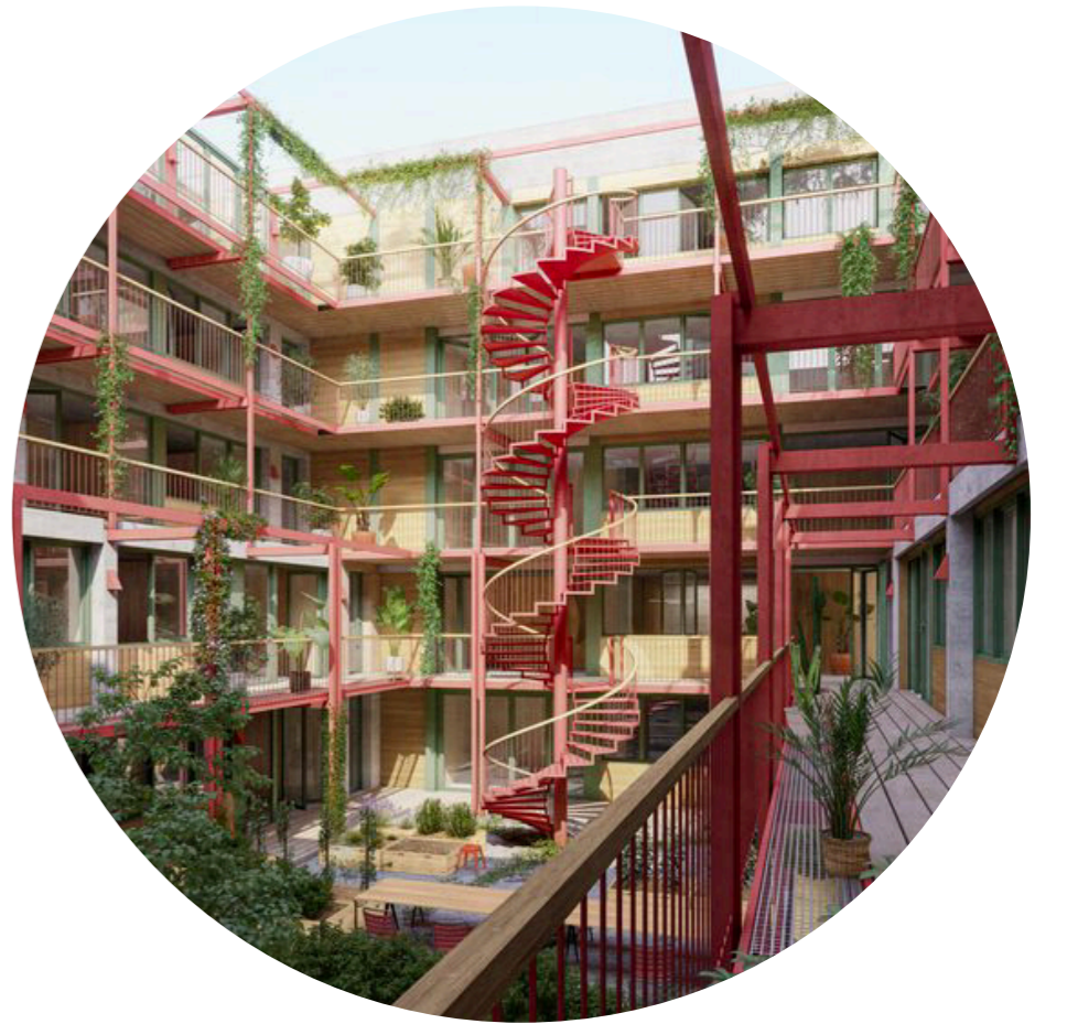
Stalen trappenhuizen in de gedeelde binnentuin
