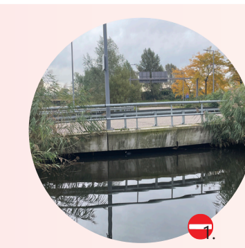
Een te lage brug blokkeert de doorlaatbaarheid
