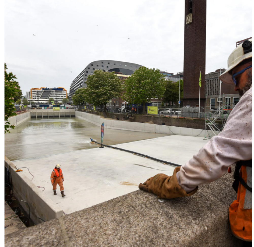
69. Bouwput RIF010. Aanleg van een surfspot in de historische steigersgracht.
