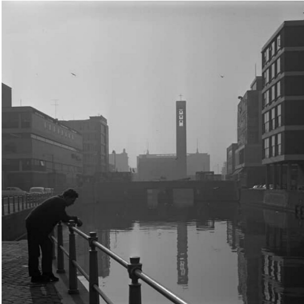
73. Zichtbaarheid van de Steigerkerk in de omgevinag
