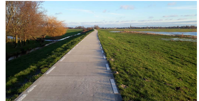
Voorbeeld van een polderkade in Noorden - Zuid Holland. De dijk in de polder is duidelijk te zien als polderkade.
