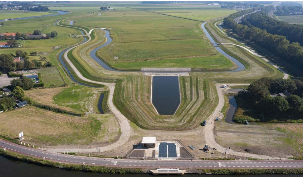
De droogmakerij ingezet als opvang van water. Referentie van de recent gerealiseerde peikberging in de Haarlemmermeerpolder. (Hoogheemraadschap Rijnland, zd)
