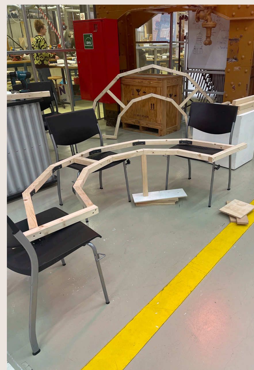
Verticale elementen, de "pootjes" worden bevestigd. Door het frame op de stoelen te leggen konden de pootjes van bovenaf geschroefd worden.
