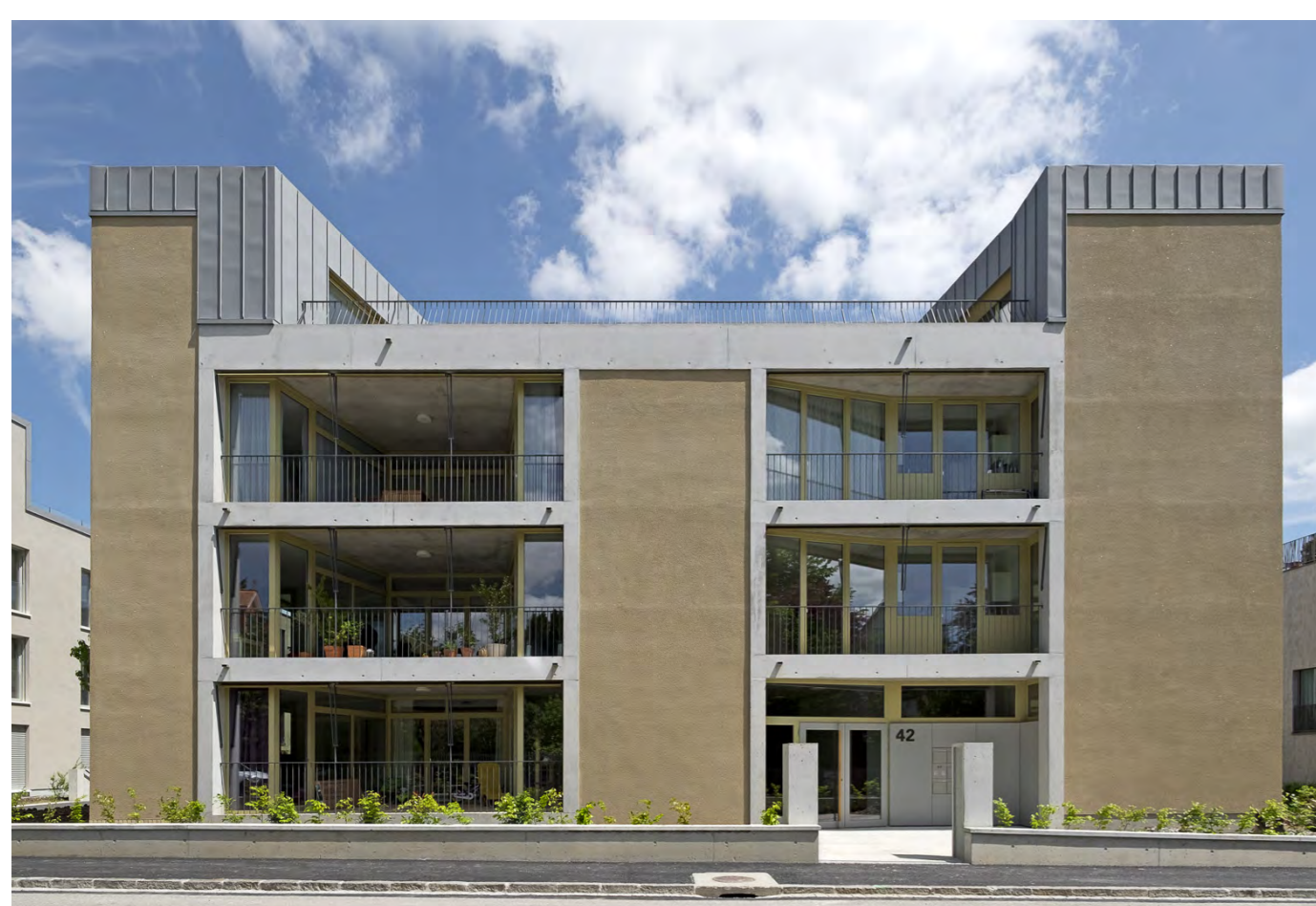
gevelbeeld D30 gebouw - met terugliggende, plafondhoge kozijnen
