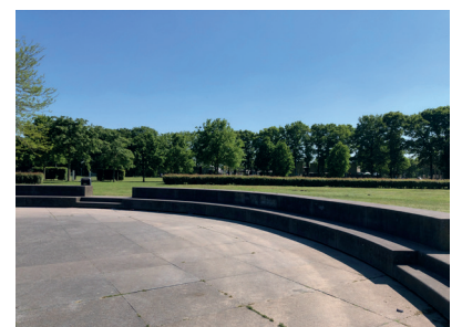
5. anti-climax, betonnen cirkel
