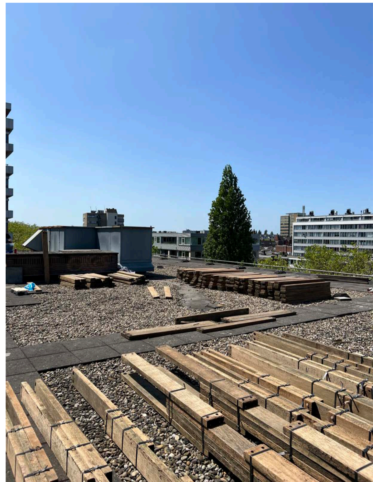
Bouwplaats inrichting op het dak
