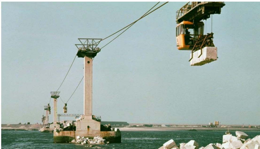
Aanleg Brouwersdam 1962 - 1971 foto uit archief Watersnoodmuseum
