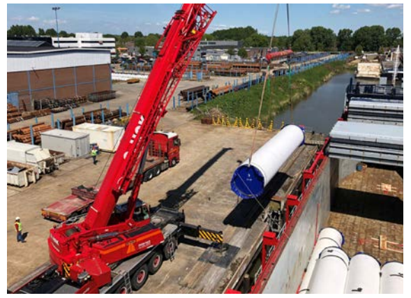
Evides pijpleiding VanLeeuwen
