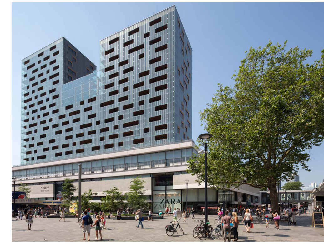
Optoppen in hoogbouw Beeld: Karel Doorman, Rotterdam, Beelings van Tilburg architecten.
