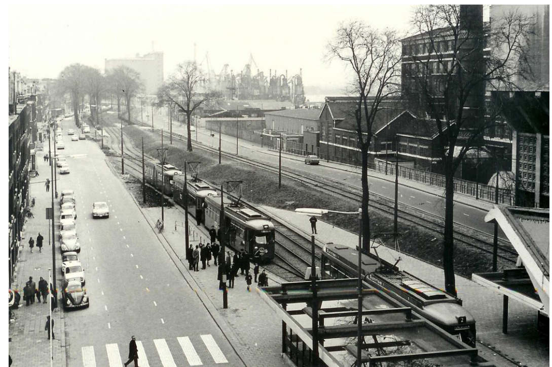
Brielselaan 1970 Met de komst van de dijk en het nieuwe metrostation verandert het straatprofiel van de Brielselaan. De dijk deelt deze in tweeën.
