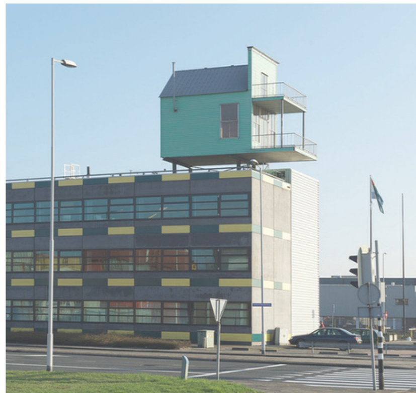
"pioneers house" Hijplaat, Rotterdam John Körmeling, 1999
