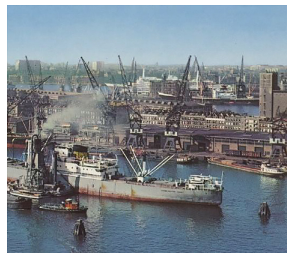
1967 HERSTEL EN MODERNISERING
