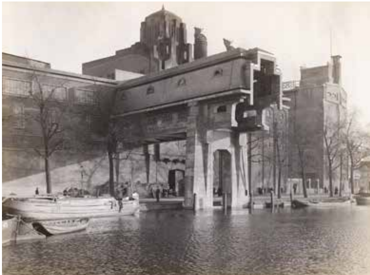
Heinekencomplex begin jaren '20
