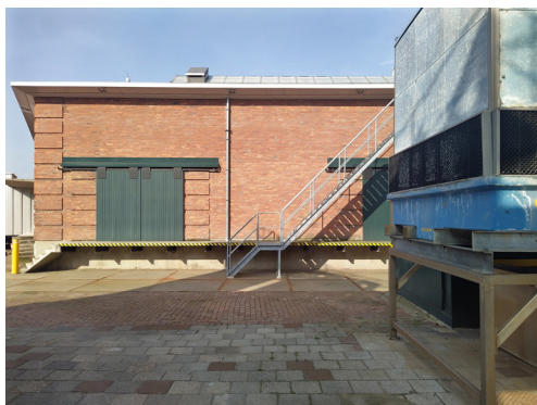
3 magazijn 2 - metselwerk gevel met oorspronkelijke schuifdeuren op perronhoogte.
