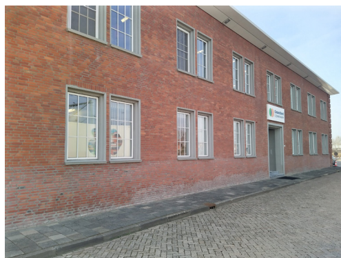
10 directievlugel - gevelritme vertelt gebruik en verdiepingshoogte. Betonnen kaders om kozijnen.
