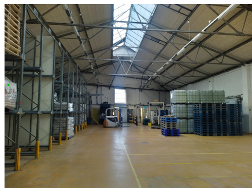
4 magazijn 2 - vrije overspanning door stalen spanten op metselwerk steunberen.
