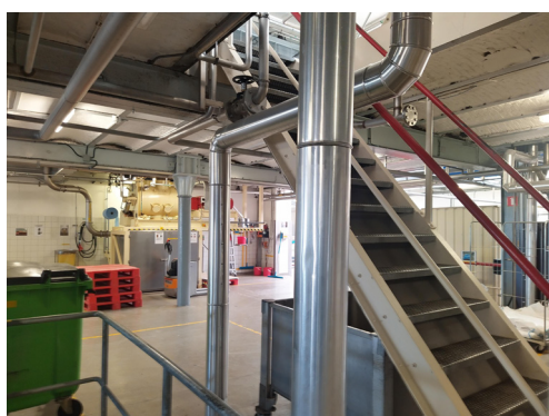
5 hoofdgebouw - oorspronkelijke troggewelfvloeren gietijzeren kolommen. sparingen in richting vloer.
