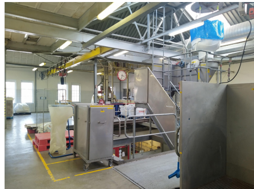
2 breitfuss - moderne staalconstructie en cassettevloer. grote sparingen en daklichten.
