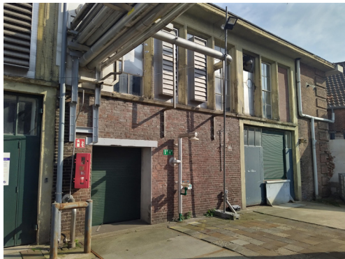
1 gevelfragment ketelhuis - betonskelet met o.a. metselwerk invulling. industriële interventie.
