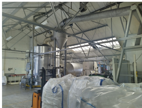
12 hoofdgebouw - bovenverdieping met historische stalen spanten. 20e-eeuws casettedak.
