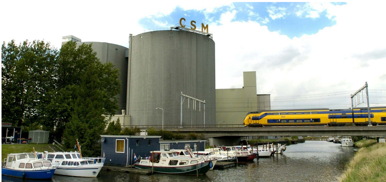
(Afb.01) Foto van de CSM-silo's vlak voor de sloop
