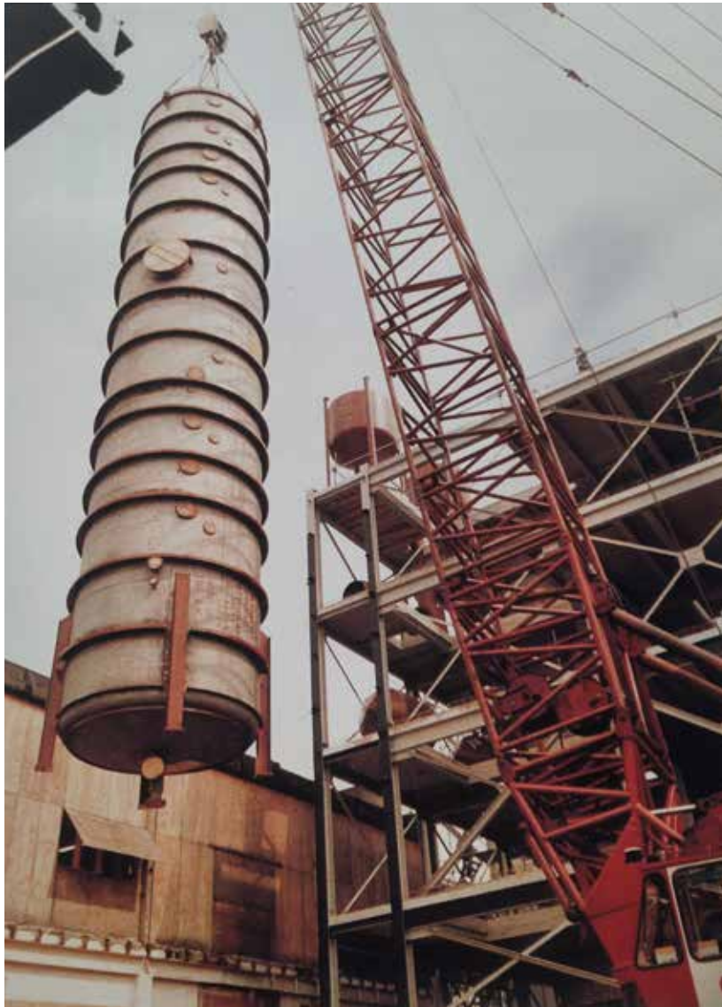
Rechts achter de kraan, het staalskelet van de stomerij
