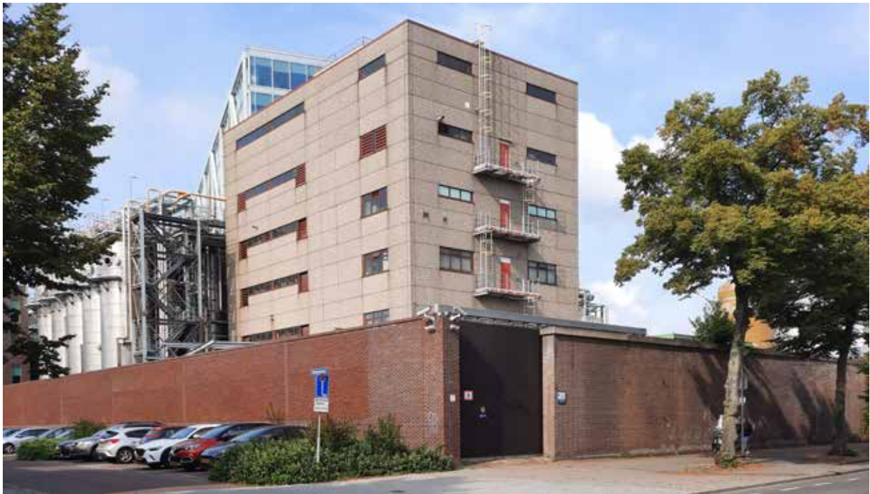
Huidige situatie hoek Nassaustraat / Roentgenstraat
