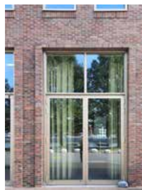
Omkaderen van gevelopening
