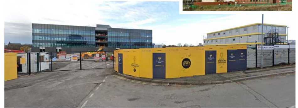
Bestaand (Politiebureau in aanbouw)
