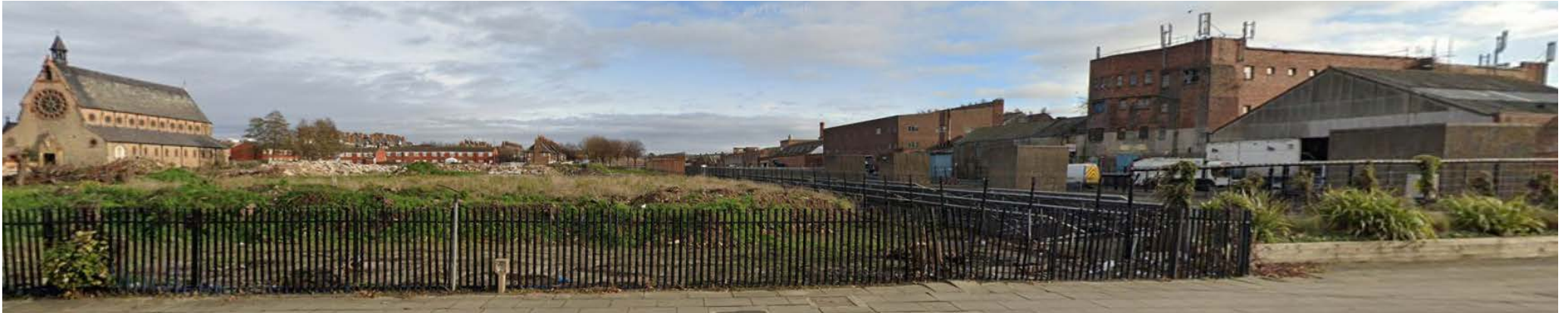
Bestaande situatie Kingsway Tunnel
