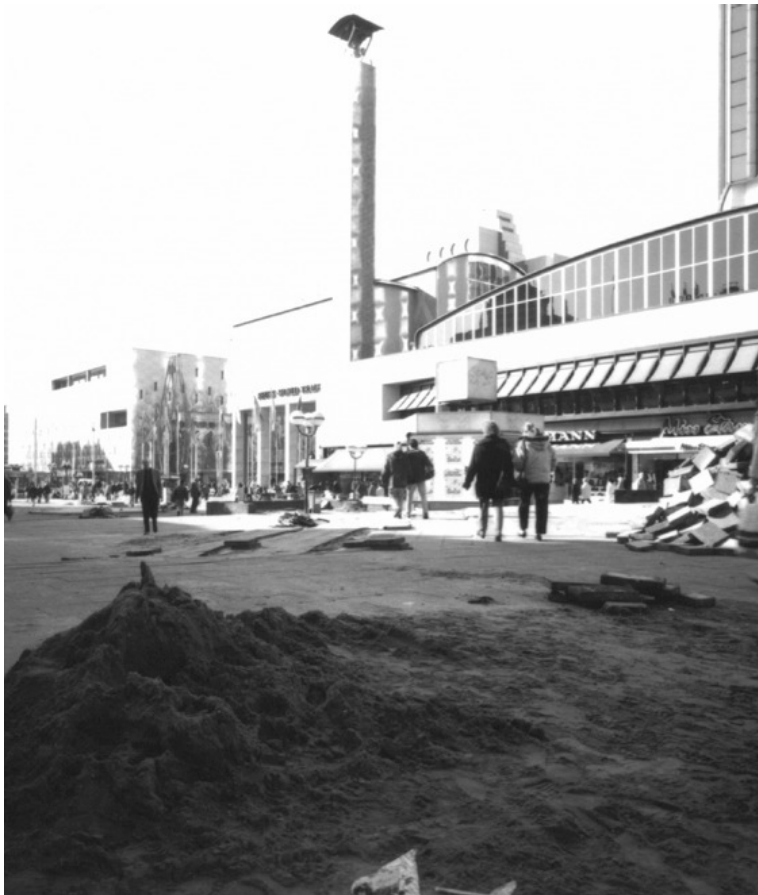
'De Koopgoot' Aanleg van de Beurstraverse tussen 1991-1996
