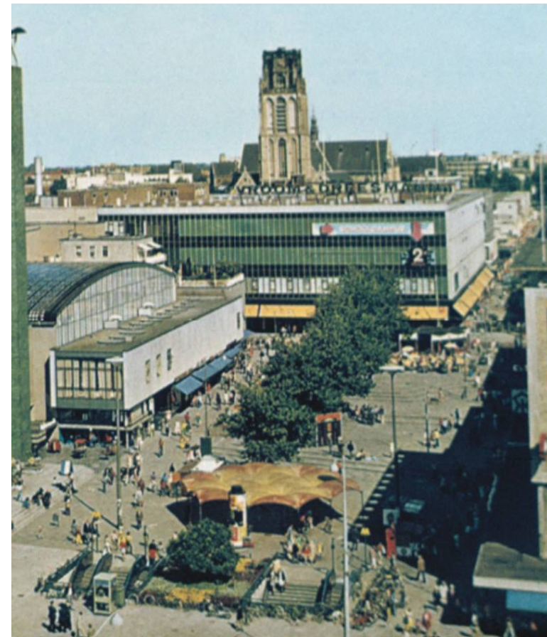
Eerste verbouwing gebouw krijgt extra verdieping en nieuwe glazen gevel
