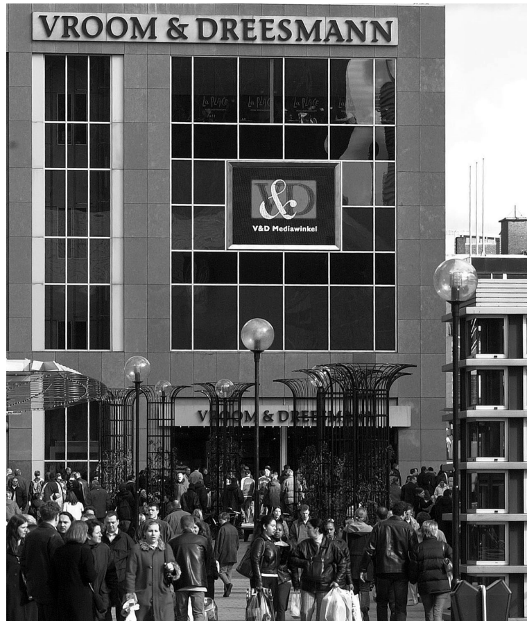
Warenhuis opnieuw verbouwd de gevel wordt aangepakt en voorzien van natuurstene gevelbekleding.
