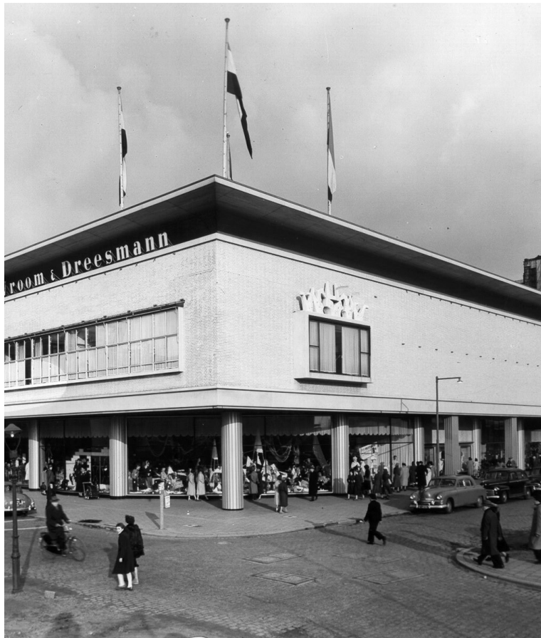
Bakstenen gebouw oorspronkelijke ontwerp door Kraaijvanger
