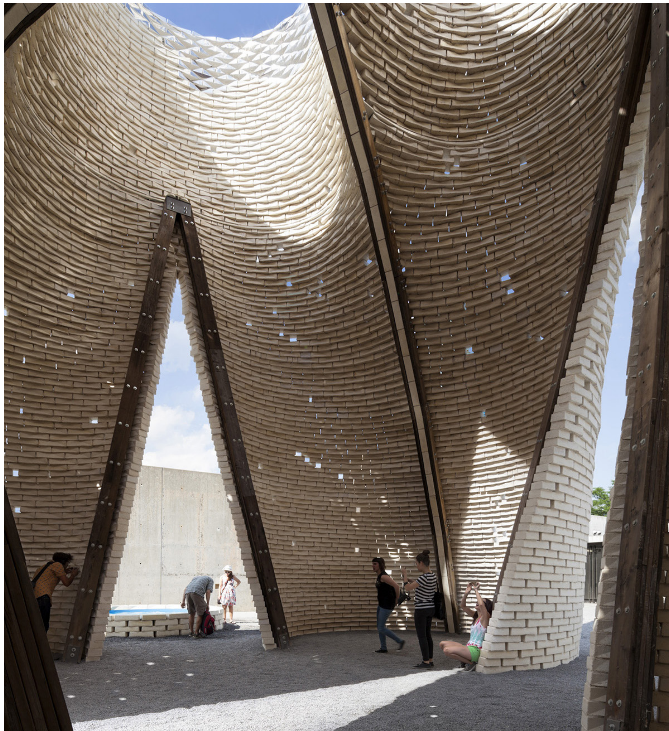
Mycelium bouwblokken op elkaar gestapeld met een secundaire constructie van hout
