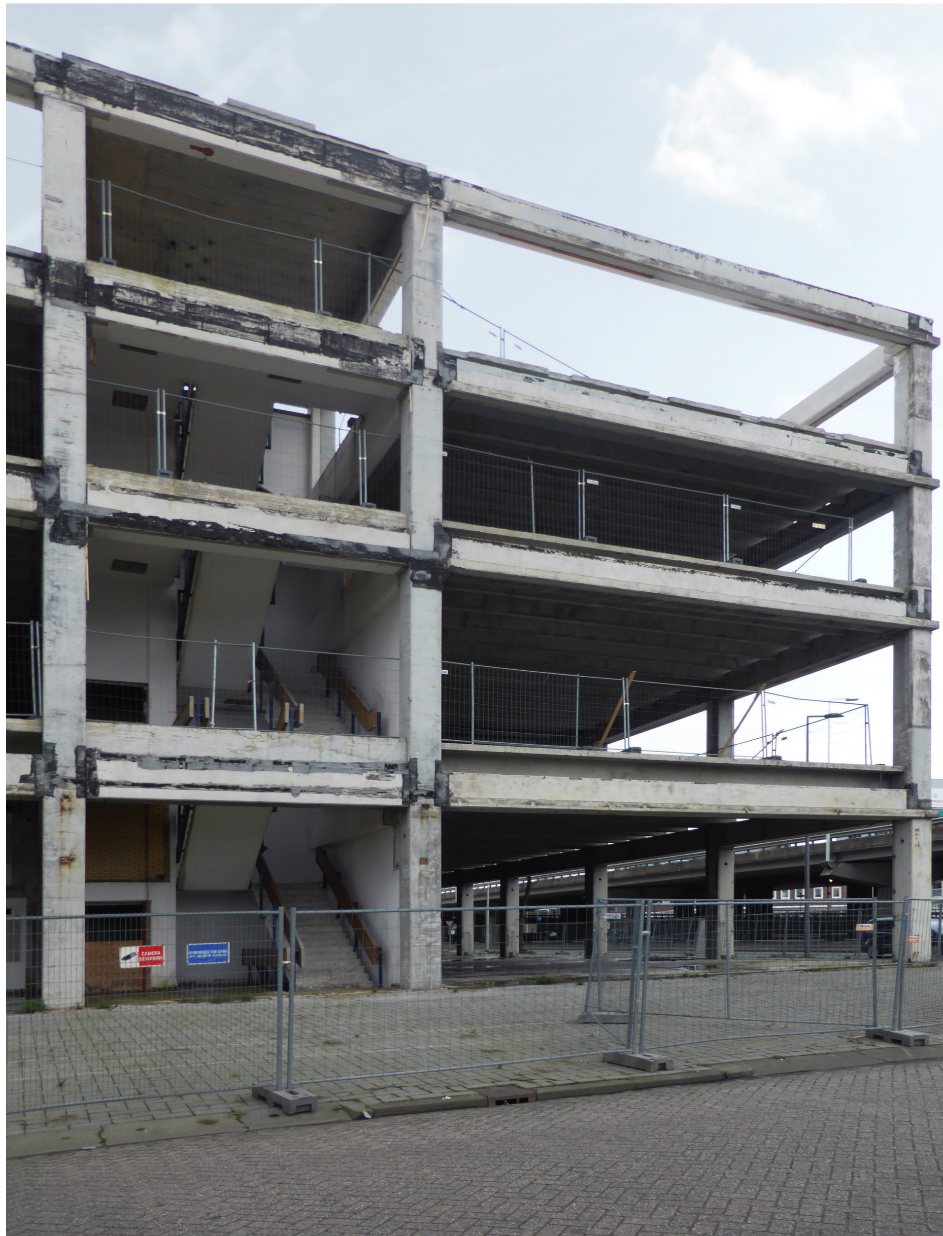
bestaande drager, loactie Spaanse Polder
