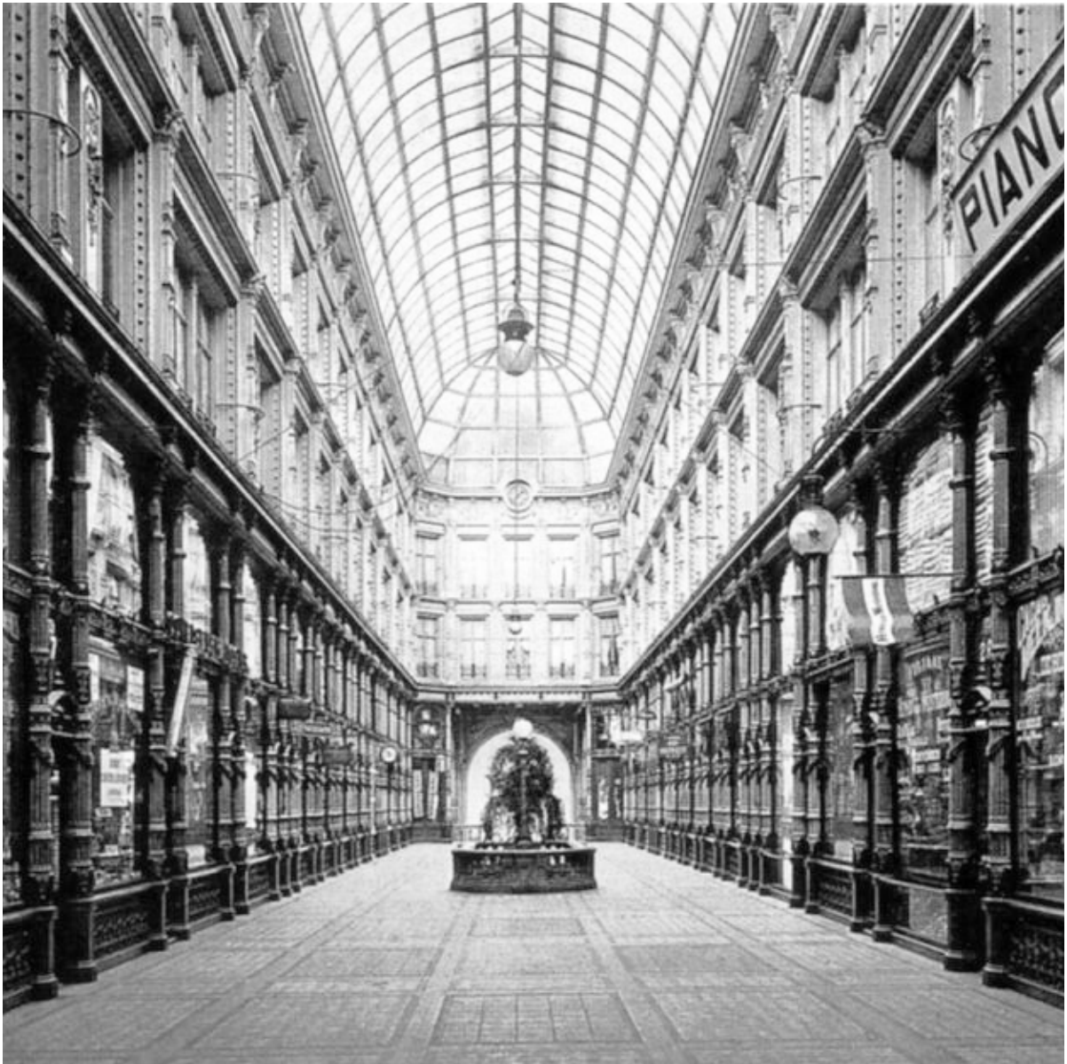
ROTTERDAM PASSAGE STEDELIJK INTERIEUR
