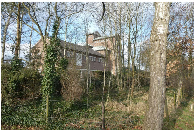
Fig. 23 (rechts) Oude silo langs de voormalige Koningslijn in Epe (januari 2021).
