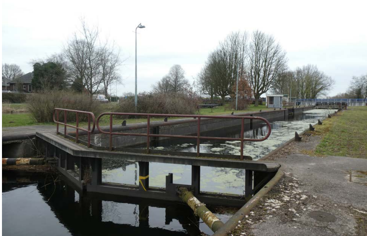
Fig. 26 Sluis bij Dieren, t.b.v. inlaat van de IJssel, waar een groot hoogteverschil overbrugd moet worden (maart 2021).
