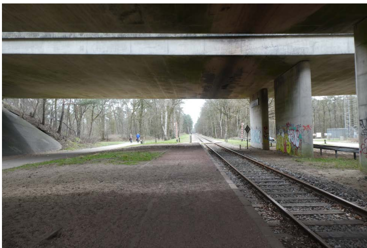
Fig. 104 Viaduct van de A50 kruist de Koningslijn bij de halte van Immenberg (maart 2021).
