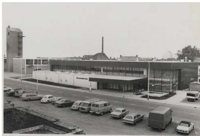
De evenementenzaal met links de slangentoren van de inmiddels gesloopte brandweerkazerne (1973) 10
