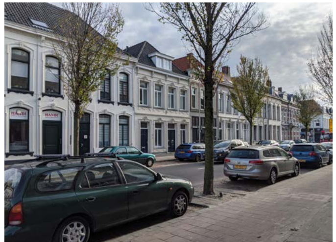
De Antwerpsestraat. Een van de straten waar hogere welstandseisen gelden voor het bouwen van een pand in de 19 e eeuwse stadsuitbreiding.
