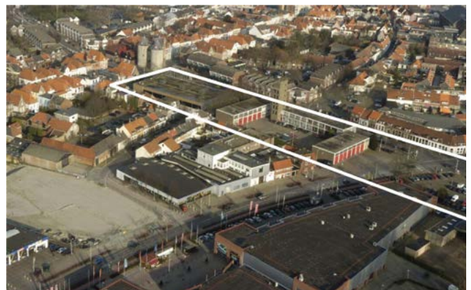
In de jaren '70 werden de evenementenhal De Stoelemat en de brandweerkazerne op het plein gebouwd. 10
