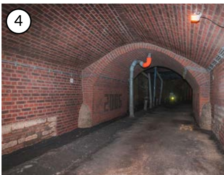
Overwelvingen van de grebbe en de in de jaren '70 aangelegde vloer met rioolbuis. De witte steen van oude kademuren is nog te zien.
