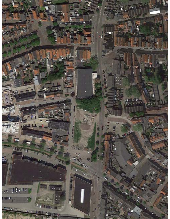
Op de luchtfoto is het braakliggende terrein aan de Van Konijnenburgweg-Westersingel te herkennen. Hier zou meteen gestart kunnen worden met de bouw van Ensemble A
