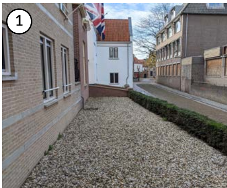
De loop van de Grebbe is te zien boven op een parkeergarage van het in 2007 opgeleverde Engelse Hof door Weyts Architecten
