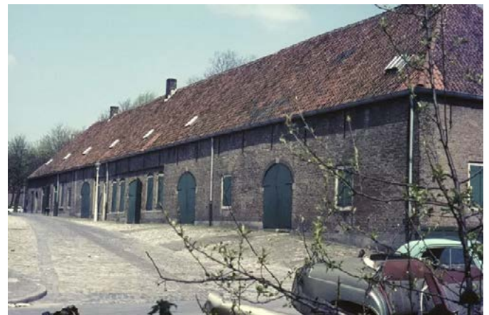
Blokstallen I voor de sloop (1965) 11
