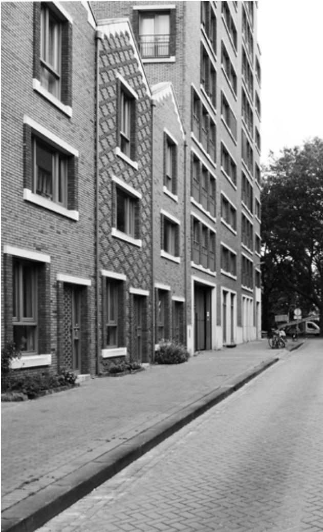
Woningbouw in de Reserveboezemstraat 1
