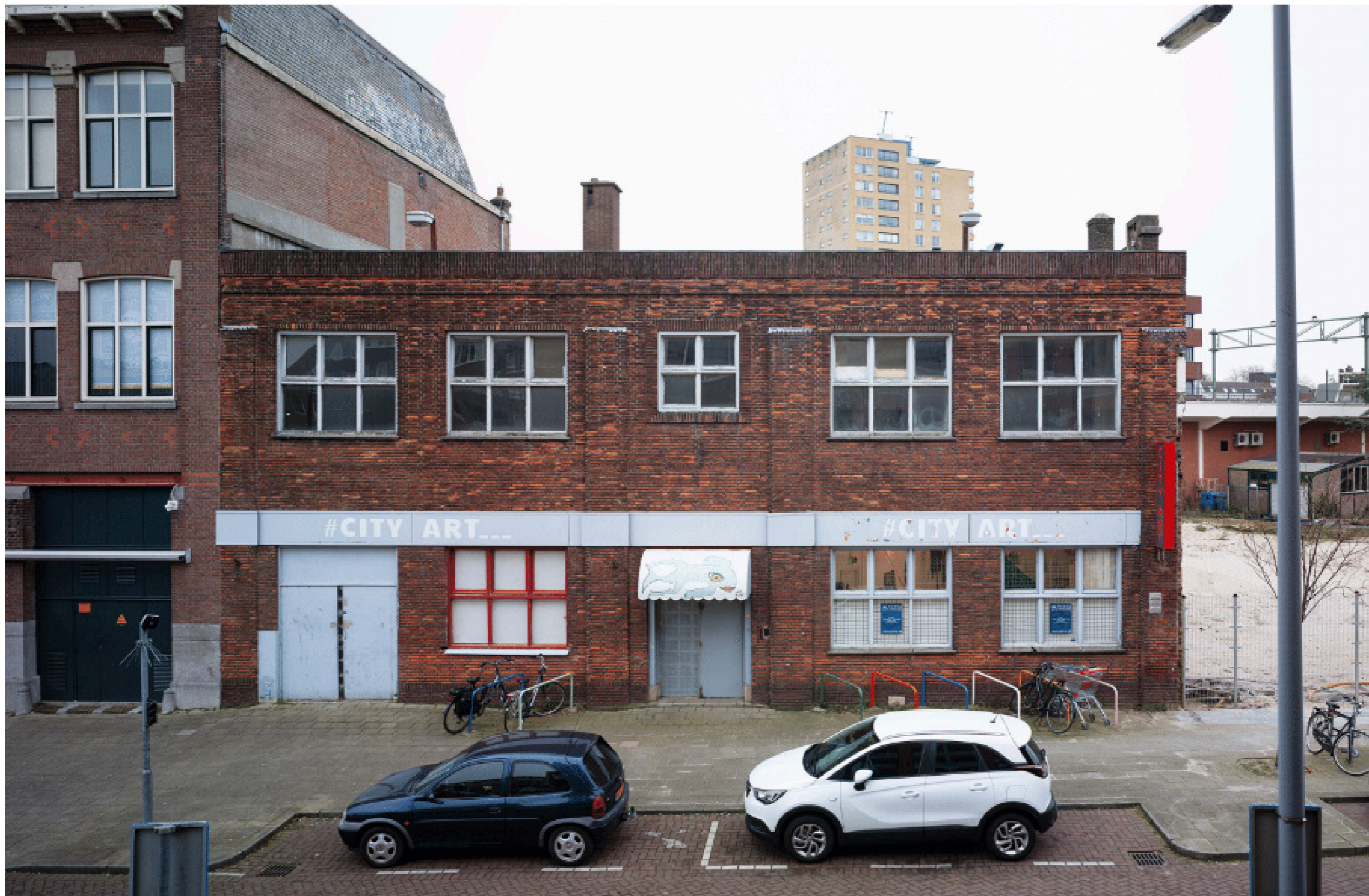
Bestaande gevel Pakhuis VICO | Foto: Rubén Dario Kleimeer
