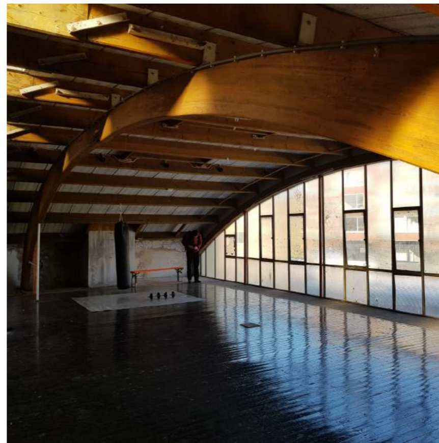
dakconstructie - 2e VD
