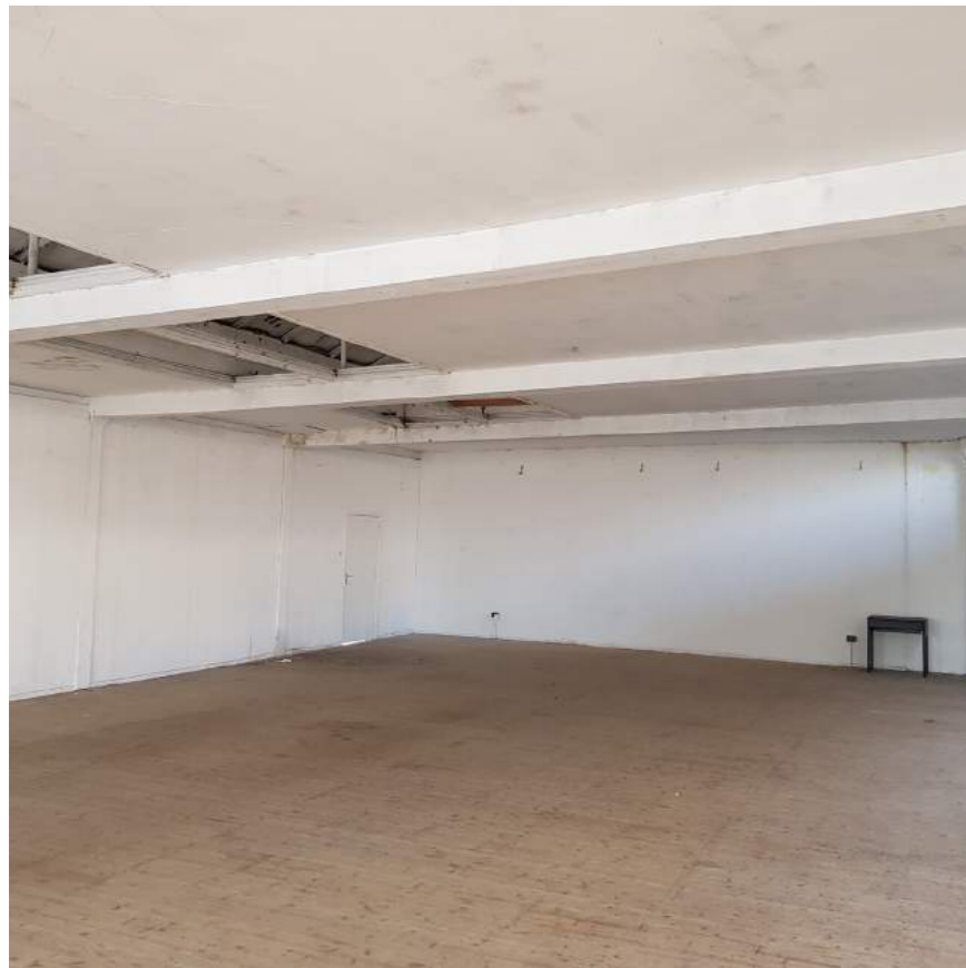
ongebruikte ruimte - 1e VD
