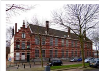
Oranjeboomstraat 109 + 111 Voormalige school, bouwjaar 1895
