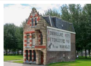
Nijverheidstraat 53 Rotterdamse cementsteenfabriek Van Waning en co bouwjaar 1898
