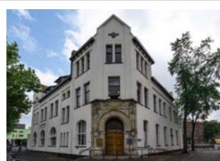
Rosestraat 123 (Rijksmonument) Rott. Tram Maatsch. bouwjaar 1903
