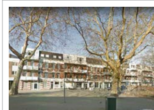
Persoonsstraat 8-132 + Nassaukade 265-32 Bouwjaar 1895
