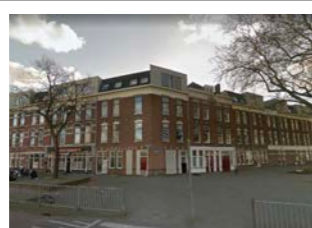
Persoonsstraat 11-67+ Nassauhaven 375-469 Bouwjaar 1898
