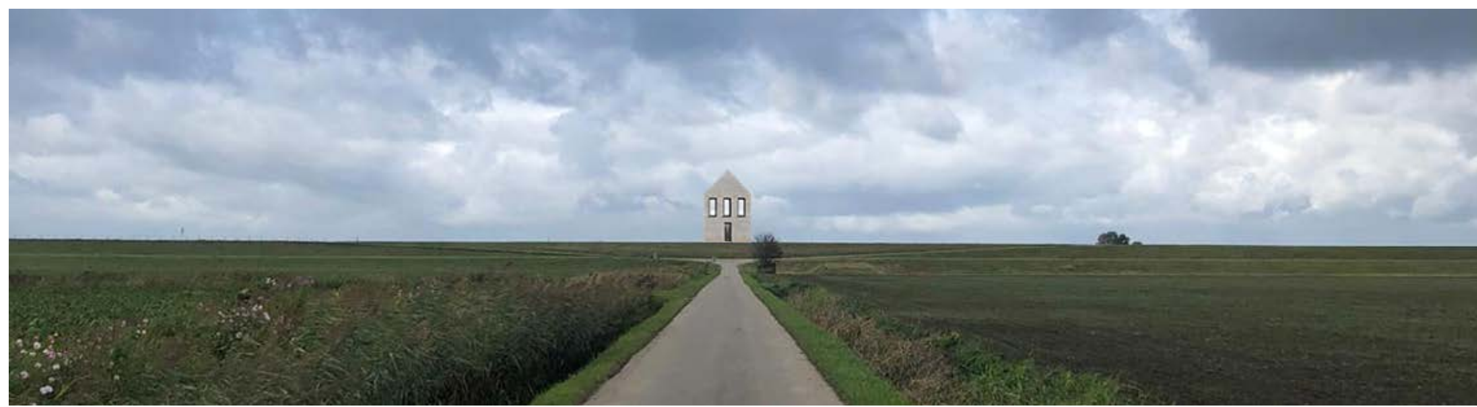
Aanzicht Zuid-Oostgevel in omgeving
