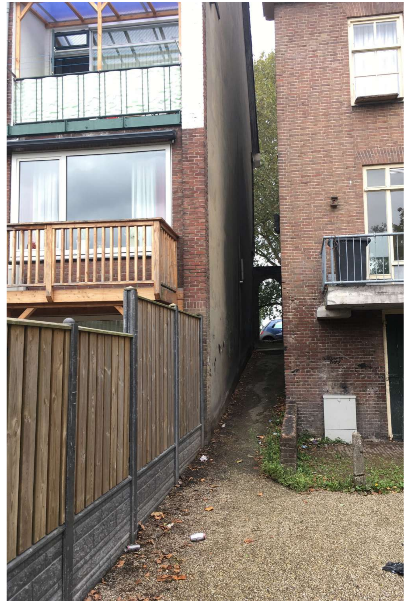
De voetgangersdoorgang naar de Groene Hilledijk en de project locatie. Deze voetgangers verbinding zal opnieuw geactiveerd worden en zo verbinding maken met gebouwen Oost en Centraal.
