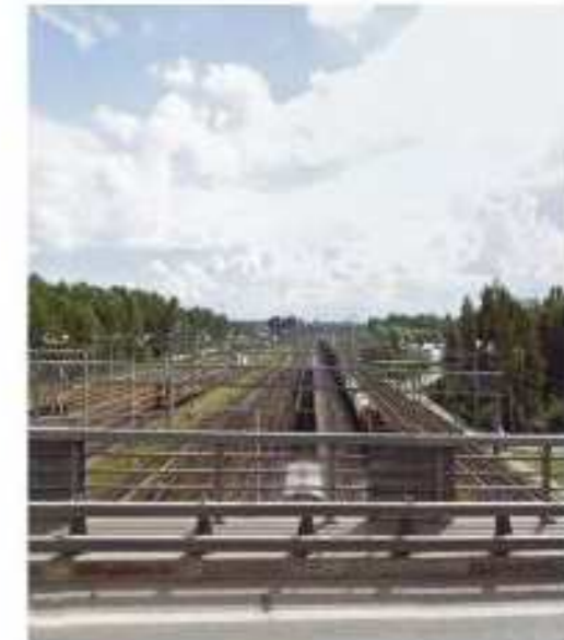
GESPLITST BRUG OVER DE WEG CONNECTIE
