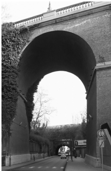
02 BORDER CITY VIADUCT GRAYTRAAT - KROONLAAN
