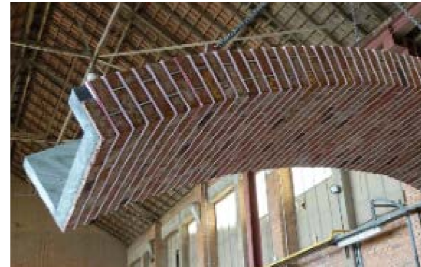
2 Prefab getoogde rollaag - Bron: Stahlbeton Albert
