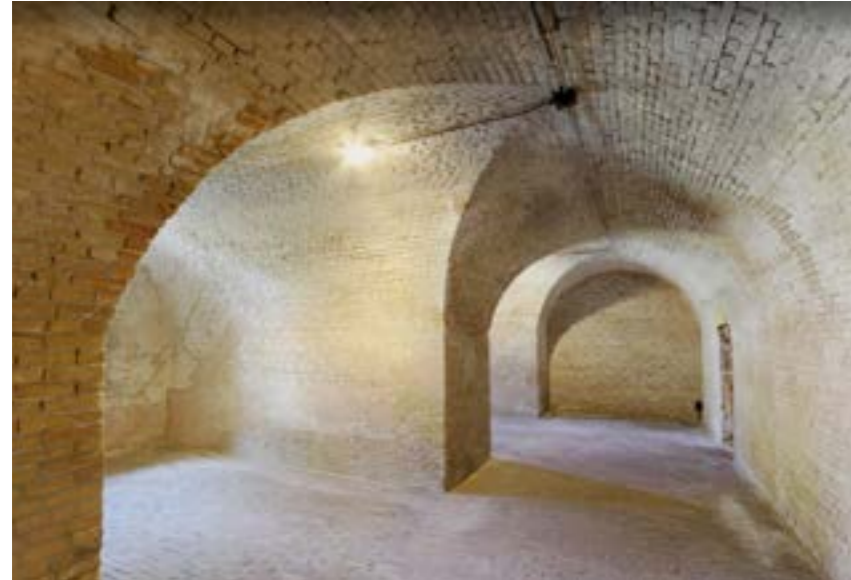
1 Gewelvenconstructie Ravelijn Bergen op Zoom
