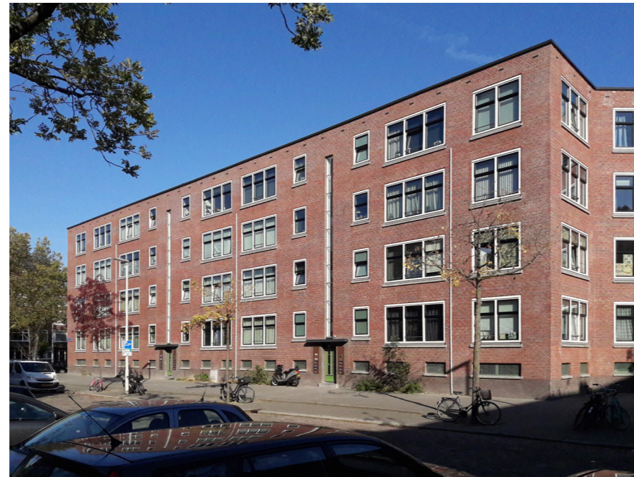
Portiekwoningen met etages en anderhalf woningen (woonverdieping + halve slaapverdieping)
