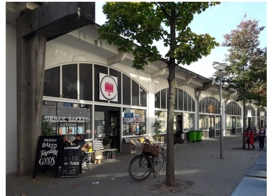
Hofbogen (voormalig) opgetild treinspoor op boogconstructie. Bogen ingevuld met puien tbv werkplaatsen
