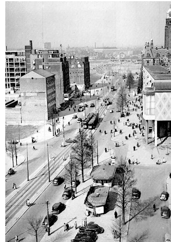
aanleg van Coolingsen als autoboulevard
