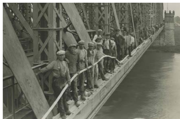
Aanleg 50kv leidingen
