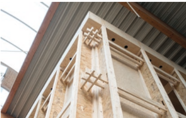
MetsäWood push-in connection | Een houten verbinding die zonder bevestigingsmateriaal in elkaar wordt gezet. Het is eenvoudig te demonteren en her te gebruiken.
