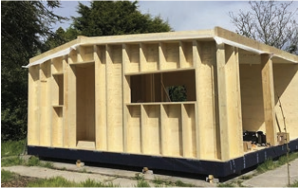
MetsäWood kerto ribwalls | Een 45mm massieve plaat in combinatie met 27mm stijlen fungeren als de dragende buitenwanden. Hierin kan de isolatie en installaties worden verwerkt.
