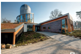
Salandse Heuvelrug - houten constructie - sterrenkijkpost
