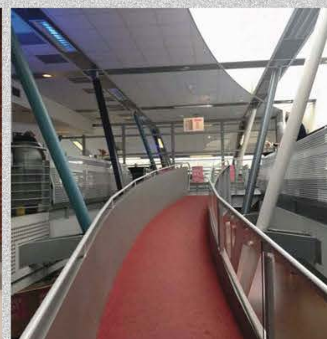
Kolommen van beganegrondvloer tot dak, De Nieuwe Veste, Herman Hertzberger
